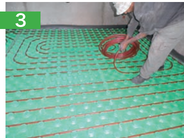
3 Placer le tube réticulé avec barrière anti oxygène Griflex PEX.
