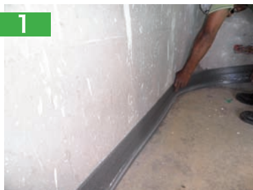
1 Mettre en place la bande périphérique.
