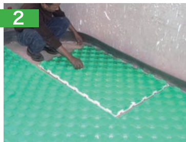
2 Mettre en place les plaques isolantes à plots griflex.
