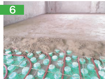
6 Couvrir le circuit avec du mortier mélangé à un additif, pour améliorer sa conductivité thermique et sa résistance mécanique.
